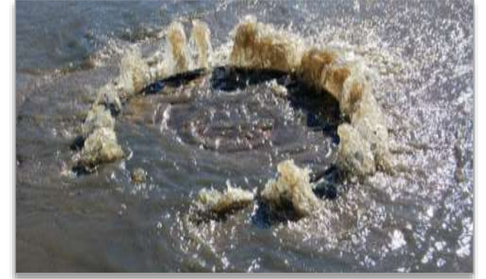
Prevent Sewage Spills Evite derrames de aguas residuales
